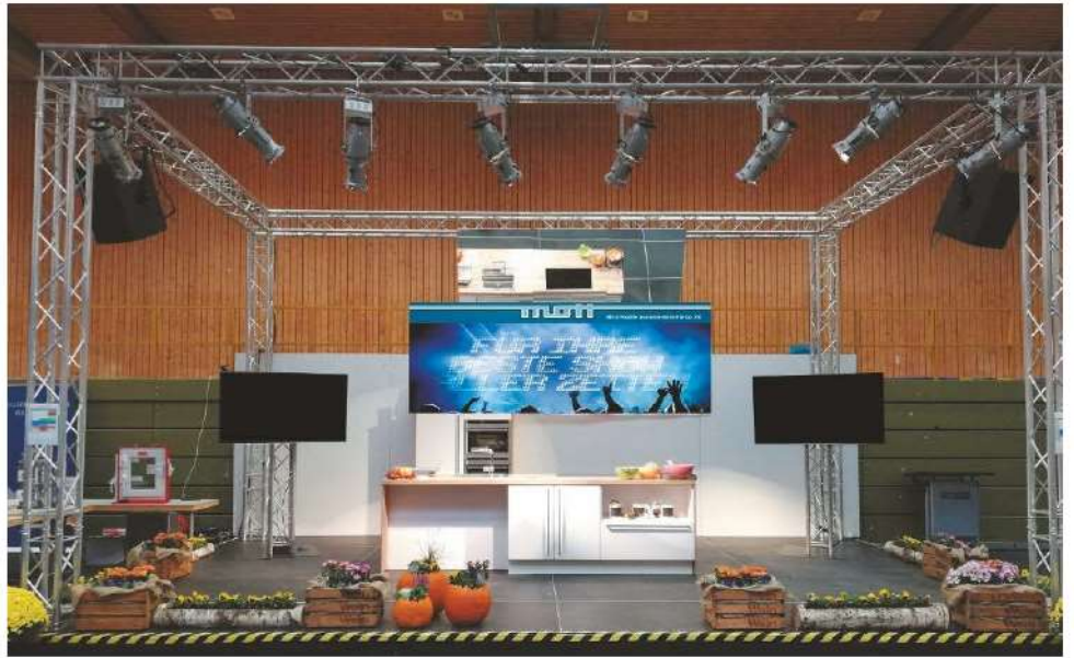
Im Einsatz Groundsupport integriert im Bühnenpodest
