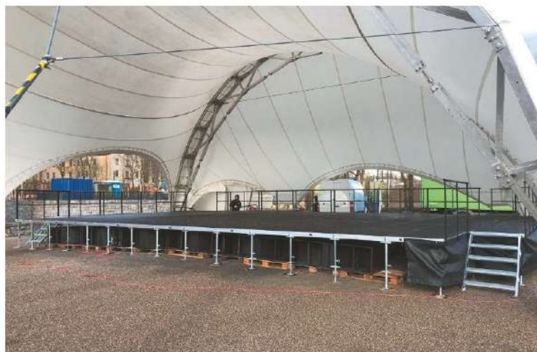
Ausnivellierung die Podeste werden mittels Spindel eingestellt
