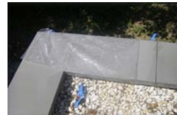
Bild 14 und 15: Fleckenbildung auf einem Aluteil durch längere Lagerung in Folie im Freien
