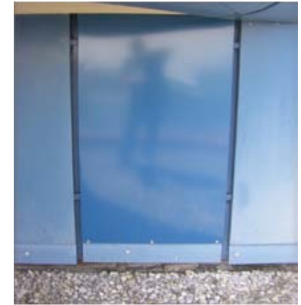
Bild 21: Detailaufnahme Metallfassade blau pulverbeschichtet mit Reinigungsmusterfläche
