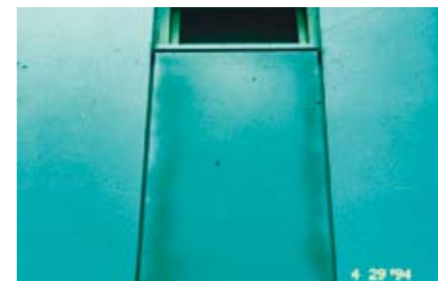
Bild 6: Bilderrahmeneffekt bei Metallic-Beschichtungen
